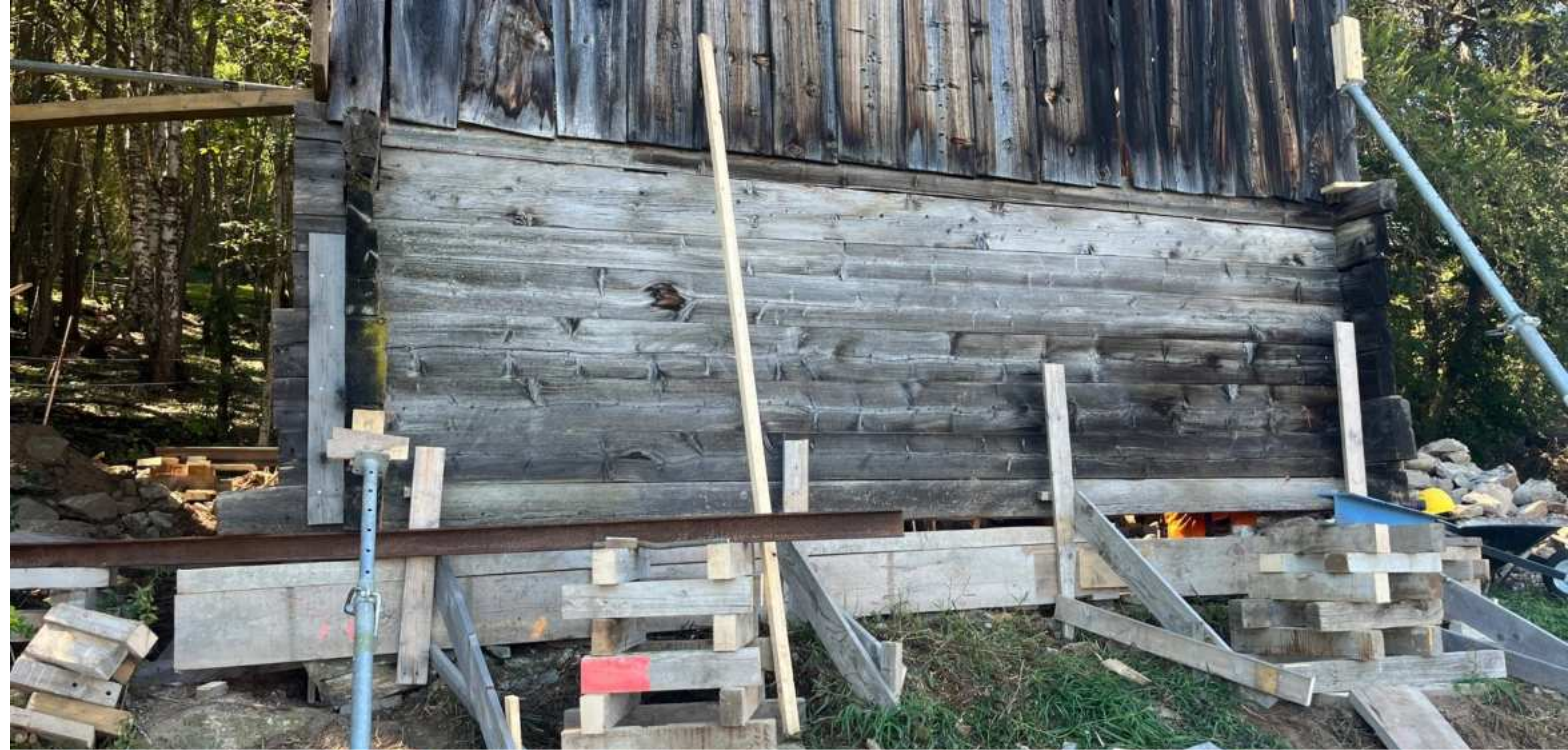
Sicherung des Blockbaus und der Ladenscheune Sanierung Grundmauern, Fundament & Bodenplatte
