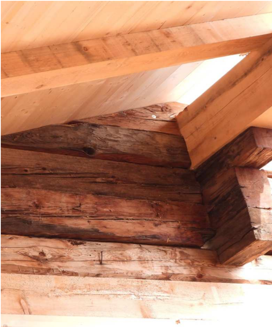
Neue Eckpfosten, neuer Riegel, neue Sparren, neue Schalung, alter „Abrost“
