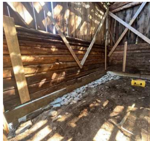
Sicherung des Blockbaus und der Ladenscheune Sanierung Grundmauern, Fundament & Bodenplatte
