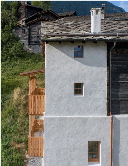
Nordfassade: der überdämmte und wieder vollständig verputzte Ständerbau auf Bruchsteinsockel
