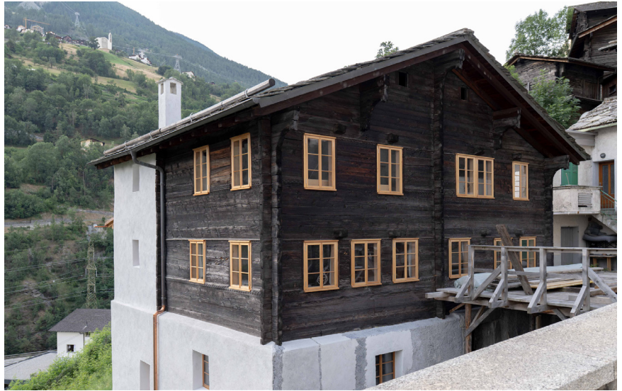
Westfassade: Blockbau mit bündigen Vorfenstern auf verputztem Bruchsteinsockel
