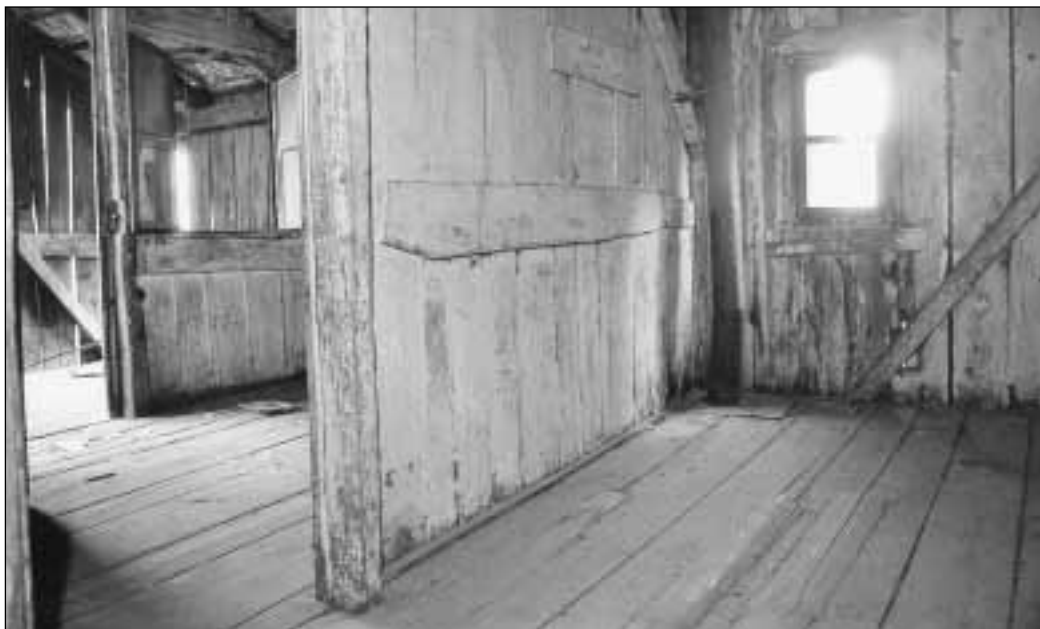
Hier logierten damals Arbeiter: Der sozialgeschichtliche Zeugniswert nützt den Besitzern der baufälligen Liegenschaften begrifflicherweise wenig.
