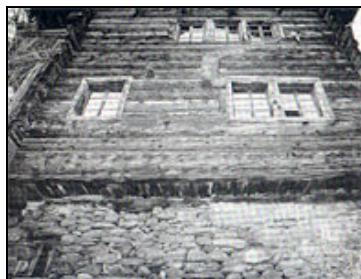
Die imposante Fassade des östlich situierten Blockbaus
