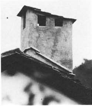
Restaurierter Kamin am «Wäbihüs», Turtmann
