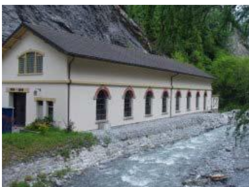
Die alte Zentrale im neuen Kleid...
